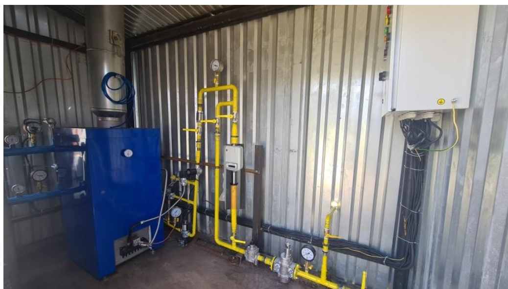
Рис. 2. Котел КВ-ЦБ на установке подготовки нефти
